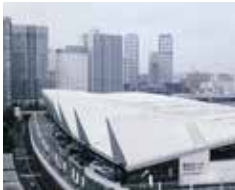
屋根に集まる雨水を利用した節水
